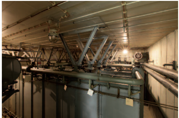
Blick auf die Vorratsbehälter für den Diesellostoff, den das Notstromaggregat benötigte. Die auf einem Erschütterungen dämpfenden Gestell montierten Tanks fassten 35.000 Liter (Raum 26).
