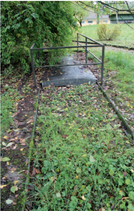
Beim zweiten Abgang ist noch die Schiebevorrichtung mit den Führungen zu erkennen, die den Treppenabgang abdeckte [2013].
