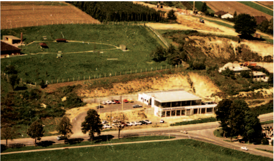
Blick auf das Bunkergelände aus dem Jahr 1968. Innerhalb des Stacheldrahtzauns bestand kaum eine Anpflanzung. Gut zu erkennen sind die Überdachung eines der beiden Abgänge in den Bunker (Bildmitte) und die Zu- und Abluftbauwerke. Die Anlage machte aus der Luft betrachtet einen unauffälligen Eindruck und ließ ihren Verwendungszweck nicht errahnen.
