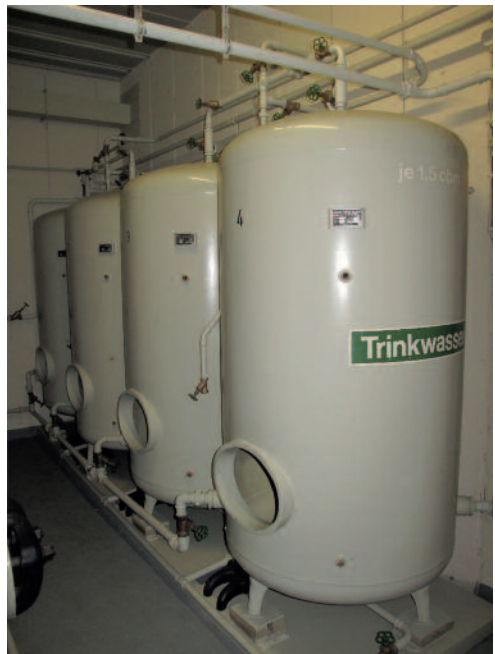
Für das Überleben des Personals im Ernstfall standen acht Trinkwasserbehälter mit einem Fassungsvermögen von je 1,5 Kubikmeter Wasser zur Verfügung [2014].
