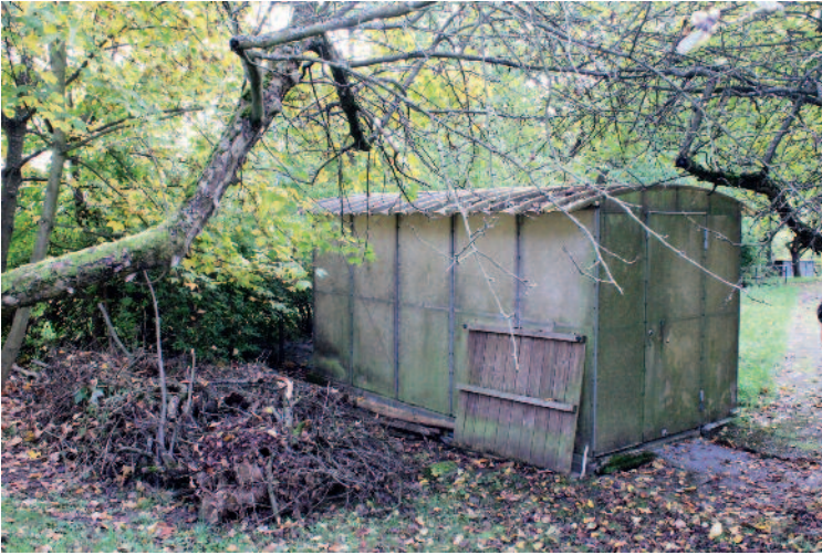
Der mit einem Schutzdach versehene nördliche Abgang zur Fernmeldeanlage [2013].
