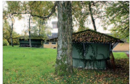
Blick auf Ab- und Zuluftbauwerk (im Vordergrund) der Anlage. Die Bauten waren so konzipiert, dass der Wind die Abluft von der Anlage weg transportierte [2013].
