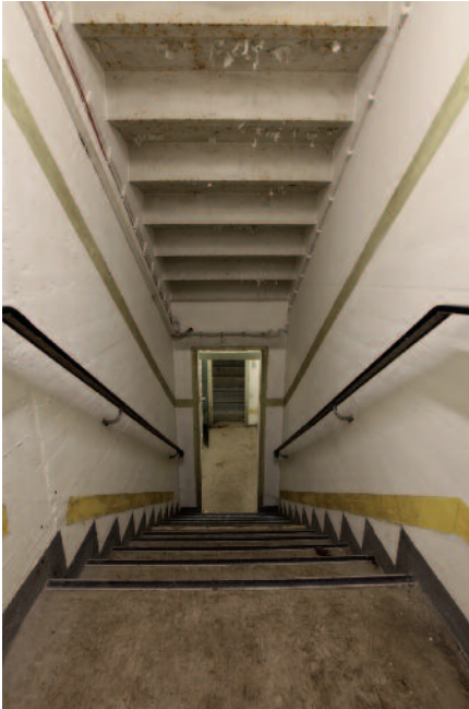
Treppenabgang in den unterirdischen Teil des Fernmeldegebäudes.
