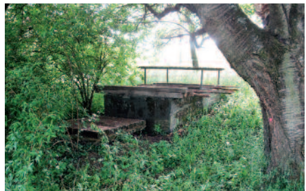
Die 300 Liter fassende Wasserstelle für das Notstromaggregat im Bunker, das zur Kühlung große Mengen Wasser benötigte [2013].
