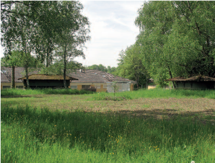
Blick über den unterirdischen Bunker auf das Verwaltungsgebäude. Auf der linken und rechten Bildseite sind die Ab- und Zuluftbauwerke für die Lüftungsanlage des Bunkers zu erkennen (2014).
