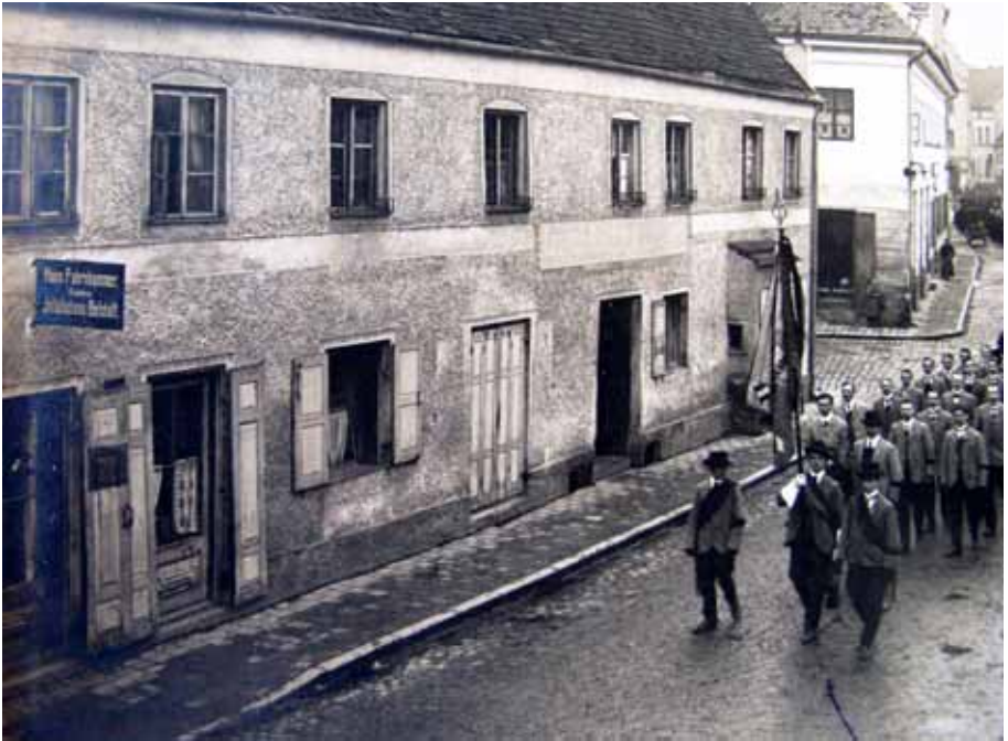
Hans Farnhammer richtete neben dem „Gasthof und Metzgerei Lutherwirt“ sein Elektro-Instalations-geschäft ein (1919).
