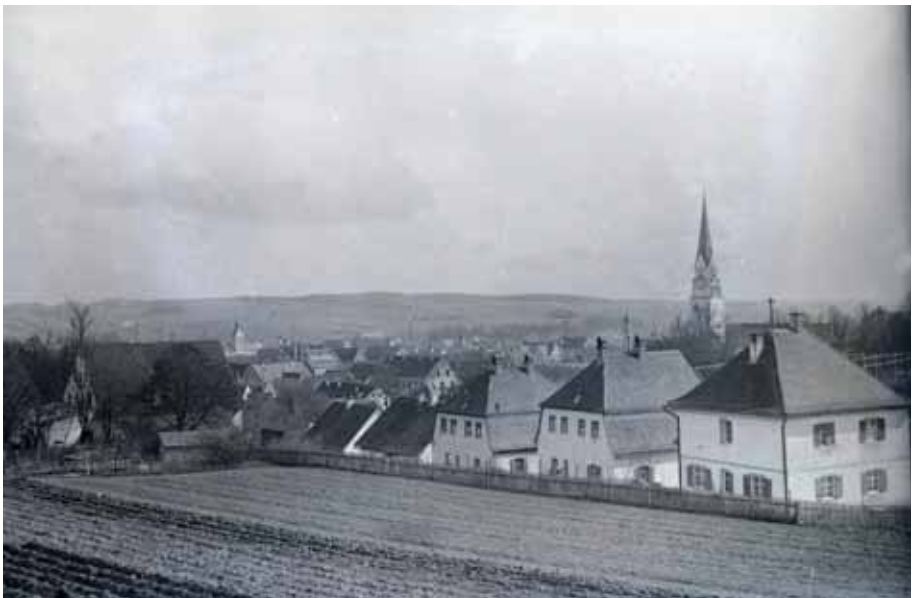
Blick von der Bortenschlagerhöhe über die Stadt (ca. 1918)
