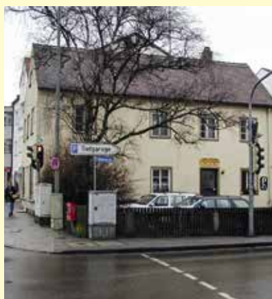
Ein altes, baufälliges Gebäude, im Sommer kochend heiß, im Winter nur mit Wärmflaschen zu ertragen
