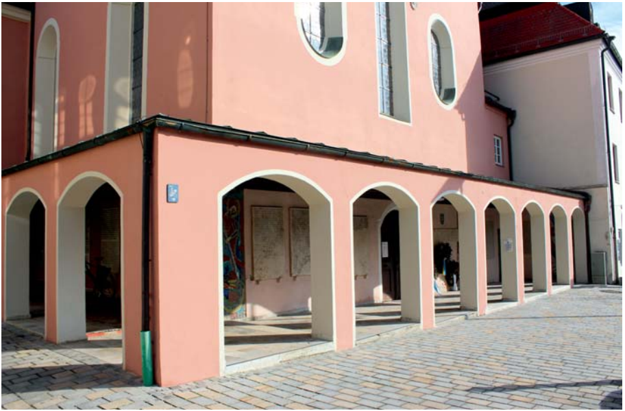
Der Arkadengang im Jahr 2019, der ebenso wie die Spitalkirche einer Sanierung unterzogen wird.
