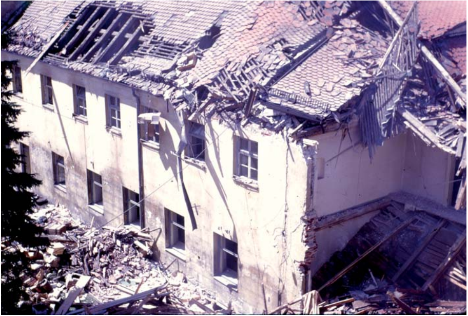
Im Mai 1969 liefen die Abbrucharbeiten am Spital, dem alten Konventgebäude, auf vollen Touren.
