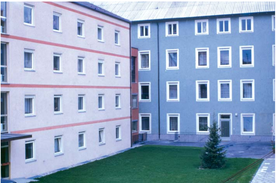
Blick auf den Neubau des Altenwohnheims (1972)
