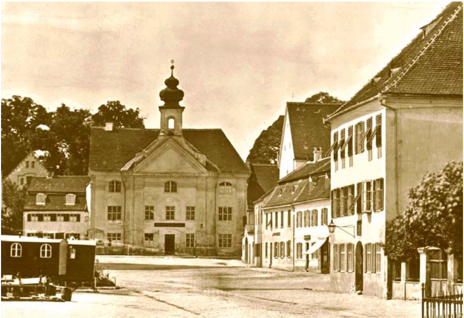
Frühe Fotografie des oberen Hauptplatzes mit Engelkapelle, der Südseite der ehemaligen Konventanlage, den Neubauten der Stadtapotheke und des Geschäftshauses Wannersperger sowie dem ehemaligen Gerichtsschreiberhaus am Standort des heutigen Landratsamtes (um 1870)
