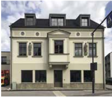
Das sanierte Balthasar-Kraft-Haus an der Ecke Scheyererer-/Hohenwarter Straße
