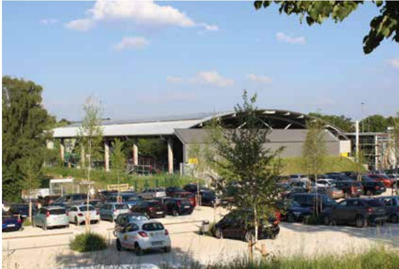
Ihre bisher größte Photovoltaik-Anlage hat die Stadt Pfaffenhofen auf dem neuen Dach des Eisstadions installiert. Hier werden im jahreszeitlichen Wechsel zwei Einrichtungen mit hohem Energiebedarf mit schadstofffreiem Strom versorgt: das Eisstadion und das Freibad.
