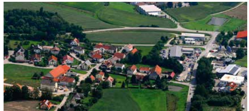
Rund 5,6 Hektar umfasst das geplante Baugebiet „Weingartenfeld“ zwischen Heißmanning und der Anton-Schranz-Straße.
