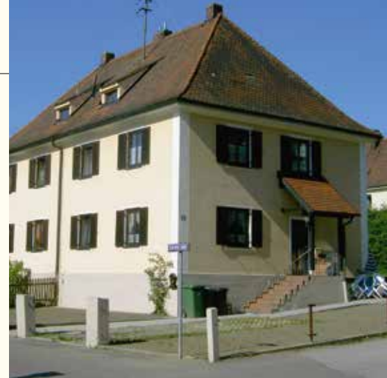
Von der Pfaffenhofener Baugenossenschaft errichtetes Mehrfamilienhaus an der Schrenkstraße (2006).
